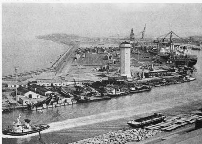
1976 - Inizia la costruzione della Darsena Toscana. L'opera si realizza tramite l'allargamento a 200 mt. del Canale dei Navicelli, per una lunghezza di 1.500 metri. Caratteristiche tecniche previste: 3.100 metri di banchina, con fondali a -13 metri, in grado di accogliere navi fino a 100 mila d.w.t., e con possibilità di manipolare annualmente sui piazzali 130/140 mila contenitori.
