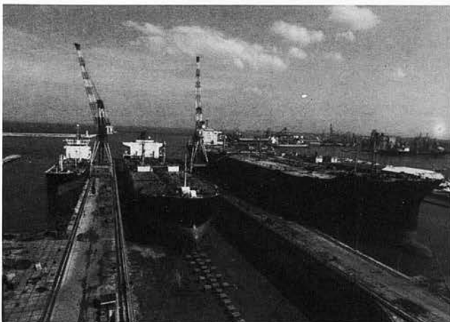
1962, 23-24 ottobre - La lotta intrapresa dalle maestranze, dagli Enti Locali e dall'intera città, per salvare il Cantieri Navale, nel complesso si conclude positivamente. A Roma è siglato l'accordo fra il Governo, l'IRI e i rappresentanti livornesi. L'accordo prevede una nuova struttura del Cantieri, l'impianto a Livorno di un grande stabilimento destinato a costruzioni metalliche del Gruppo Comefi, l'ampliamento della «Spica» e della «Cementeria», nonché la realizzazione di un grande bacino di carenaggio (mt. 350x56) per navi fino a 317.000 d.w.t.
