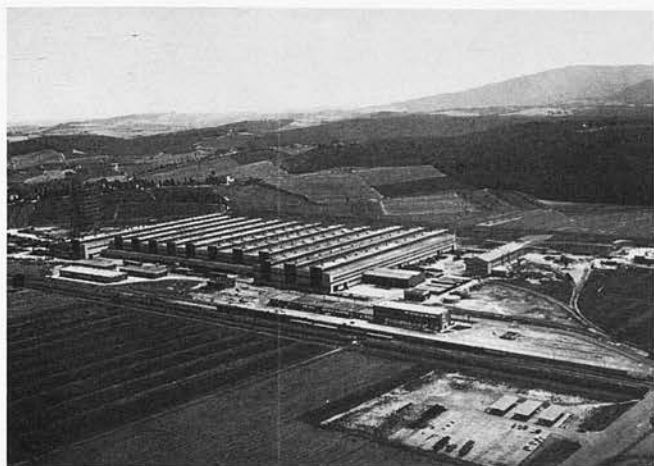
1964 - Nella piana di Guastalle entra in produzione il nuovo stabilimento «Costruzioni Metalliche Finsider S.p.A.» (C.M.F.). La fabbrica è dotata di macchinari ed attrezzature tra le più moderne del mondo. Queste le caratteristiche tecniche: area totale mq. 372.000, area coperta di lavorazione ed uffici mq. 57.000, potenza installata KVA 7.500, capacità di produzione annua t. 100.000, binari a scartamento normale e ridotto m. 5.220, gru a ponte di portata varia n. 62.
